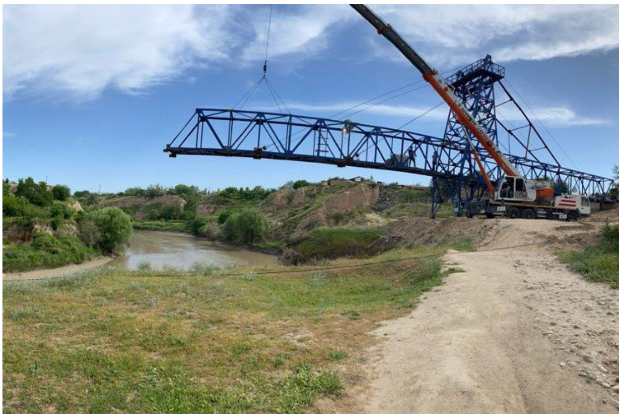
1-rasm. Osma-vantali ko‘prikning montaj jarayoni.
